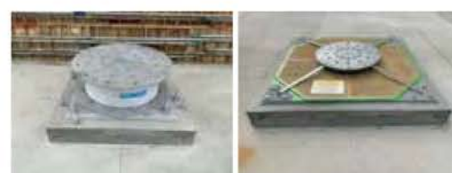
▲免震装置据付状況
