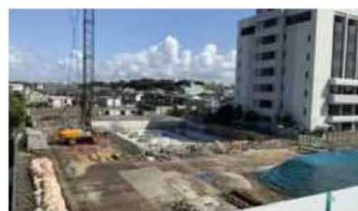
▲基礎工事が進み、免震装置を据え付けました
