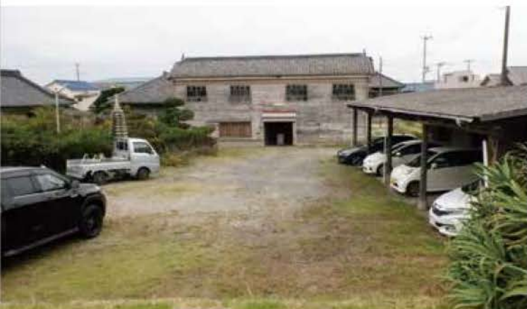
▲山側から主屋を見る・作業庭をはさみ洋館は缶詰工場
