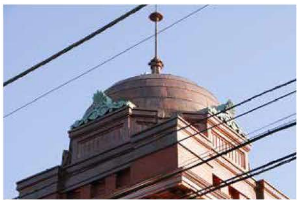
▲改修後の資料館ドーム屋根
