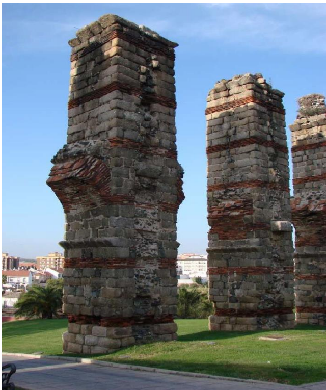
↓柱のディテール レンガが挟み込まれているのがとくわかる。柱を繋ぐアーチもレンガ作りである
