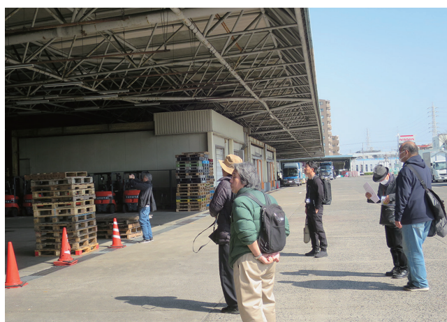
▲卸売場棟の大屋根を見る
