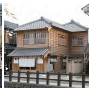
前面小野川右岸道路からの写真申請建物と大和堀
